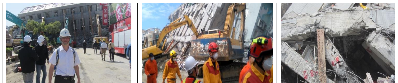
2016 年 2 月 6 日上午 3 點 57 分，高雄美濃芮氏規模 6.6 地震，最大震度為臺南市新化 7 級，造成 16~17 樓維冠大樓倒塌
